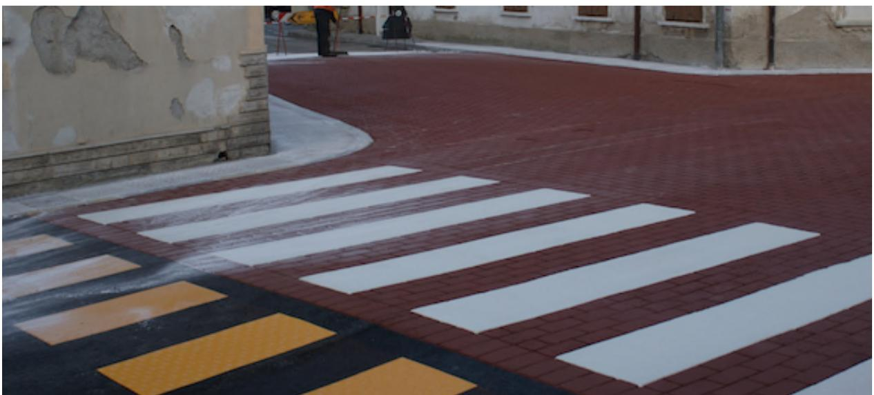
*Figura 2.3 – Esempio intersezione rialzata con finitura in Street-print*
